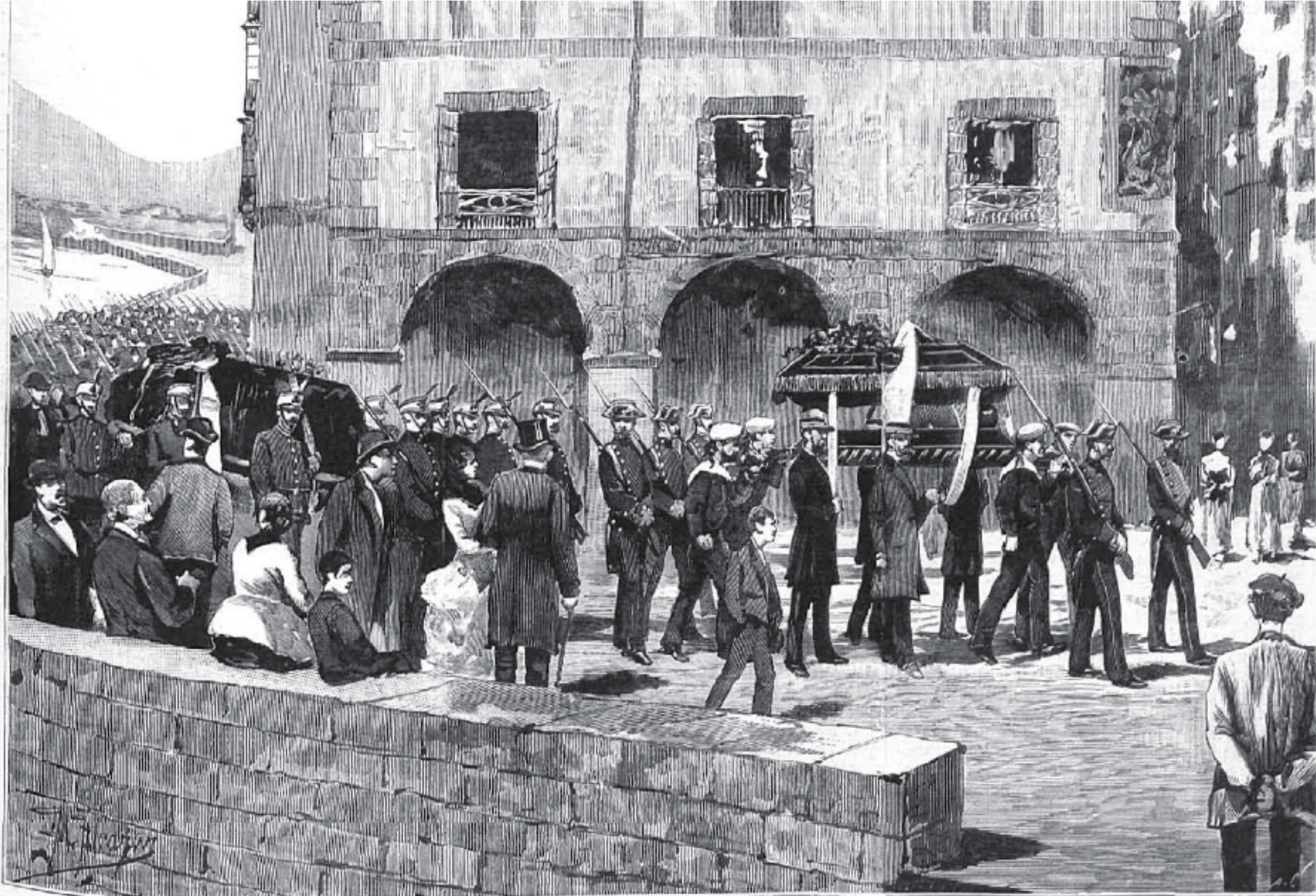
CASTRO-URDIALES (SANTANDER).—TRASLACION DE LOS RESTOS DE MILITARES HERIDOS EN LOS COMBATES DE SOMORROSTRO y fallecidos en el Hospital municipal, en 1874, al cementerio de la villa.—(De fotografia remitida por el alcalde, Sr. Villota.)
